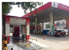
加油站/燃气站
